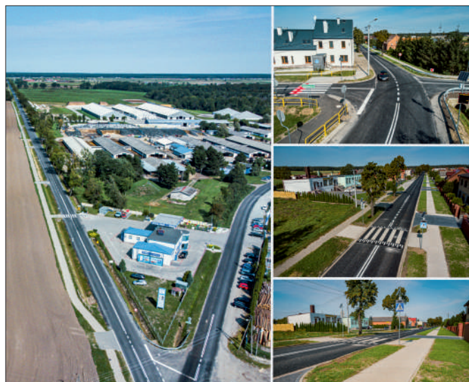
Z której strony by nie spojrzeć, nowa droga robi wrażenie (źródło: www.powiat.gostyn.pl )
