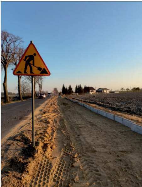
Budowa ścieżki rowerowej. Widok od strony Siedlca...
