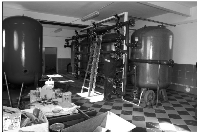
Stacja podczas przebudowy
